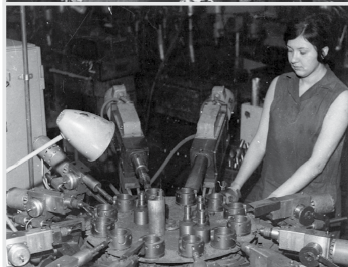
Jednouúčelový stroj pro vrtání, n. p. Pal-Magneton (1975)
